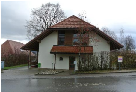
Kindergarten Stähliweg Messen
